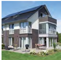
Construcción de viviendas
