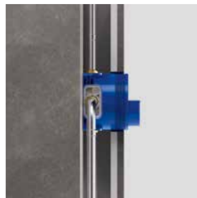
Installation sur le mur
