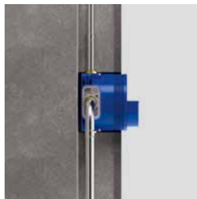
Installation dans le mur
