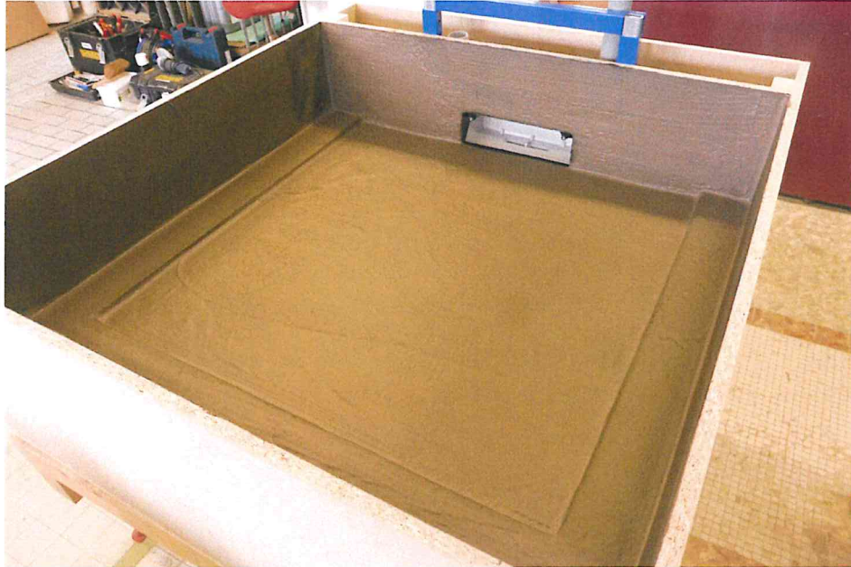
Bild 1: Vorbereitetes, abgedichtetes Becken mit Wallway-Wandablauf
