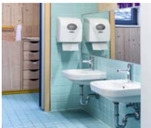
Die Waschtische wurden in Griffhöhe der Kinder montiert
