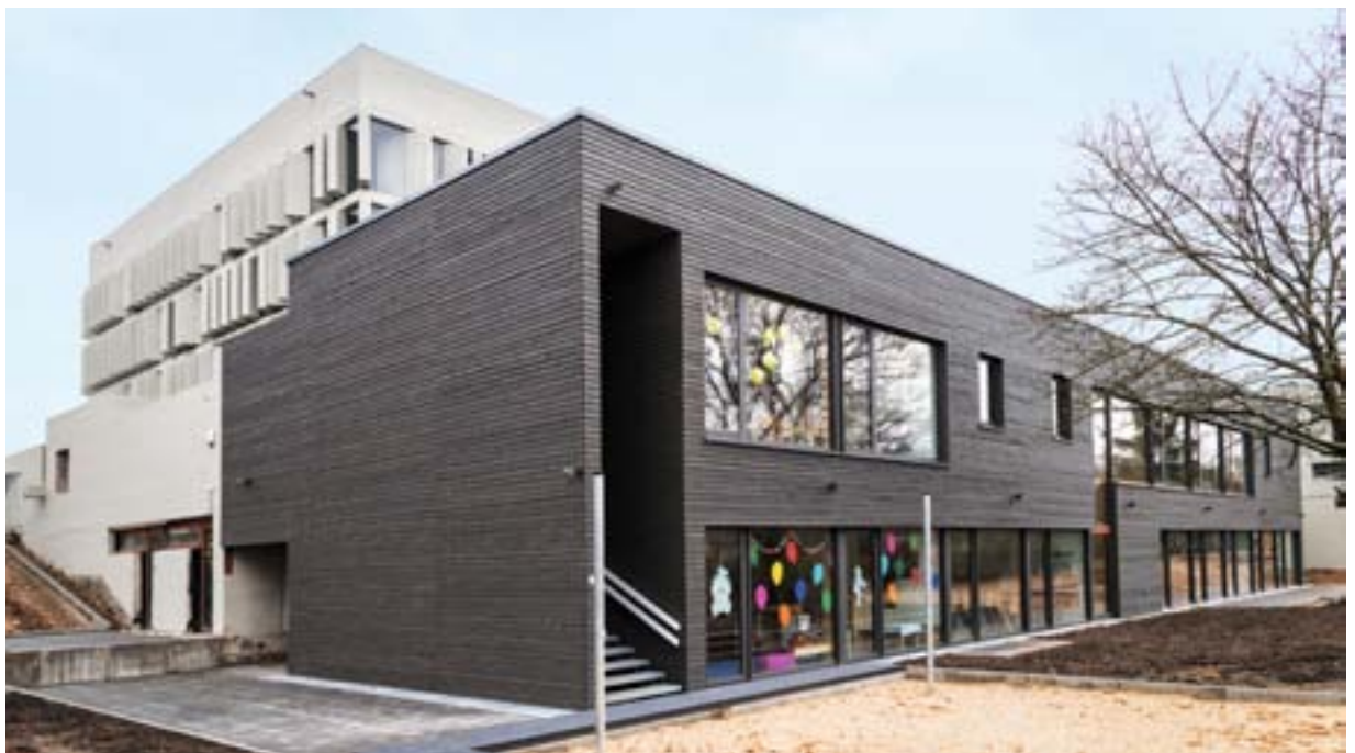
Der neue Anbau in Massivholzbauweise mit den Gruppenräumen
